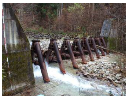
流木捕捉式治山ダムの設置
