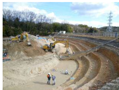
ため池の堤体を補強している状況
