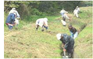
水路の泥上げ・草刈り作業
