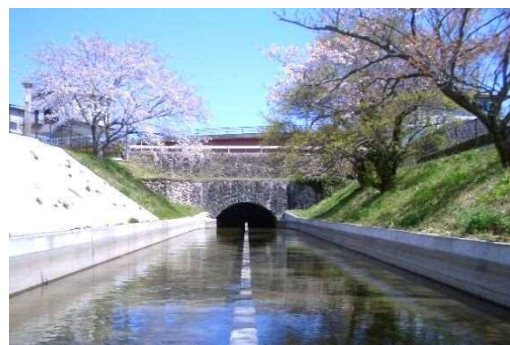
牟呂用水第1号樋門（人造石工法）
