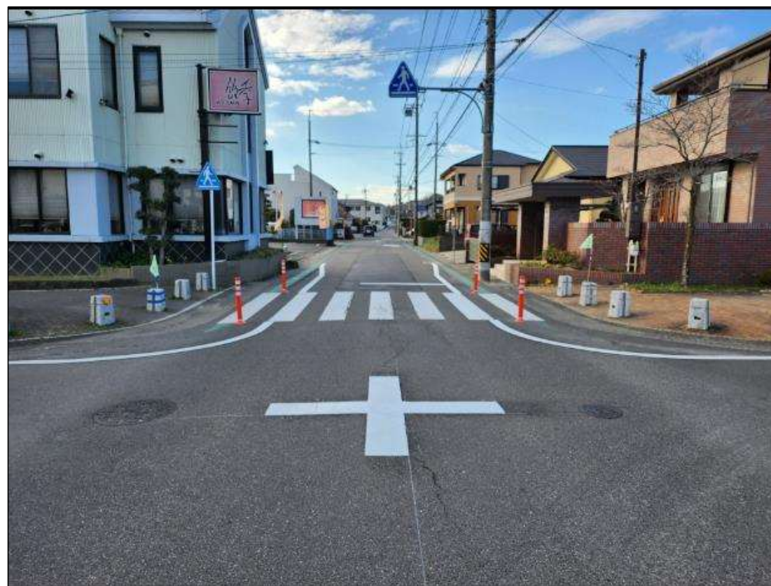
③ 横断歩道のある交差点を外側線とポストコーンで狭さく（市）
