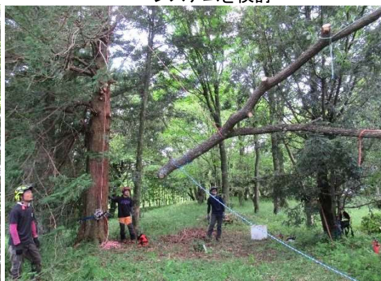
太い枝をカットし、安全に下ろす
