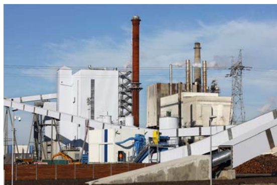
製紙工場に隣接したバイオマス発電所(左)
