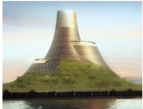
英国で建設中のバイオマス発電所 高さ 85m、発電能力は 49.3MW ティーズ川周辺の景観に配慮したデザイン
