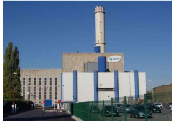
メスのバイオマス発電所 (45Mw)
