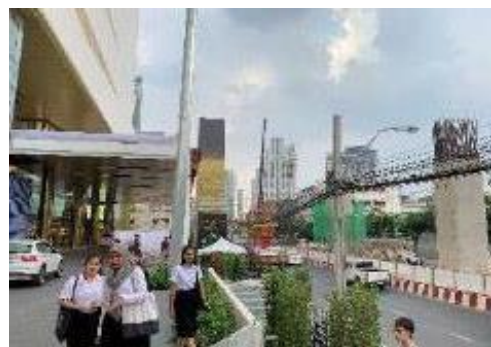
(建設中のゴールドライン)
