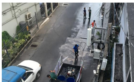
(散水車の様子)
