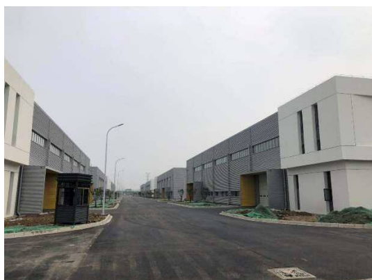
間もなく整備が完了するレンタル工場群
