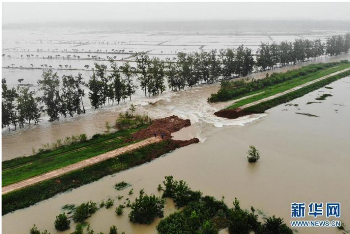
安徽省滁河で人為的に爆破された堤防から低地に流れ込む水（出典：新華社）
