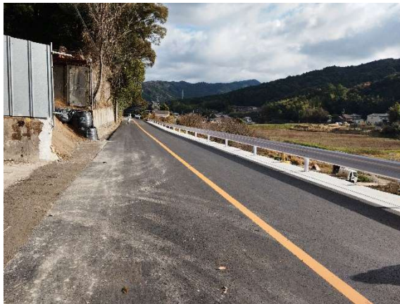
・復旧工事完了（現在）
