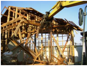
Bina gövdesinin yıkımı
