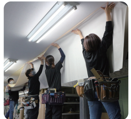
社員研修の様子（天井クロス貼り）
