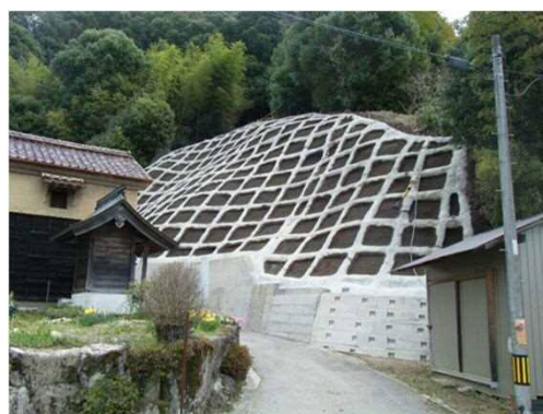
【治山施設の整備】
