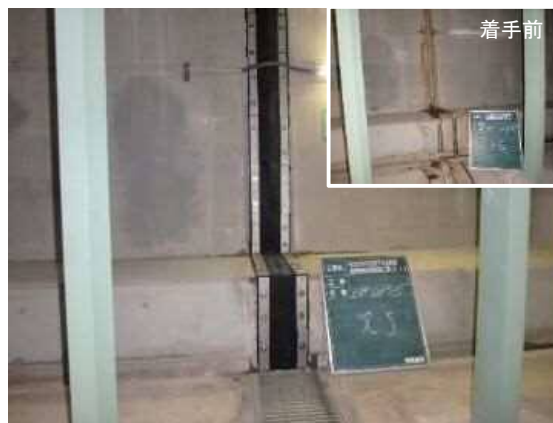
【処理場施設の耐震化】
