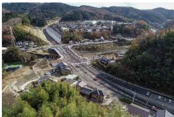
【国道301号 松平バイパス】 (豊田市)
