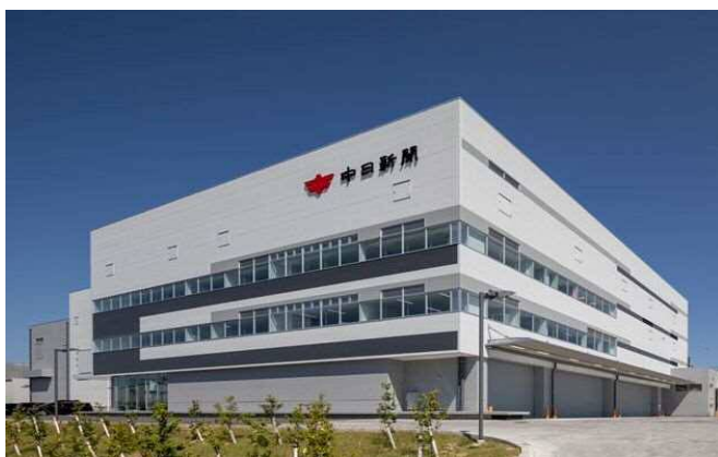
【BCP対応の印刷拠点】
