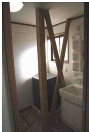
【戸建住宅の耐震改修】
