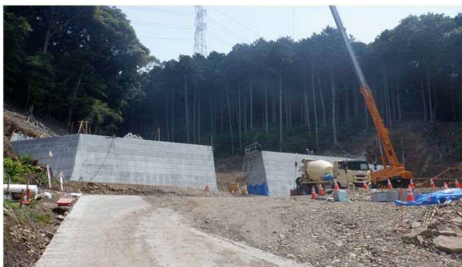
【砂防堰堤の整備（山崎沢）】
