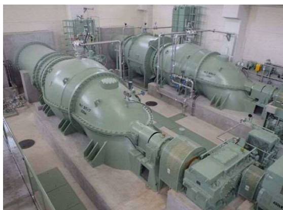
【整備完了状況】
