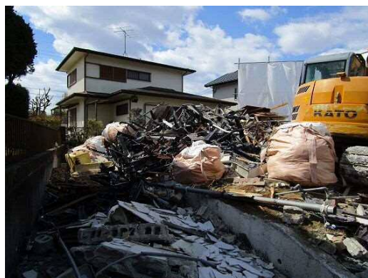
【解体工事現場の様子】
