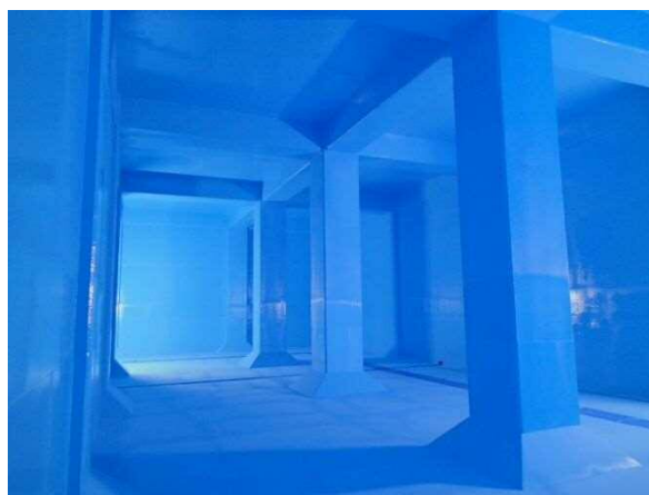
【知多広域調整池1池 (地下式)】
