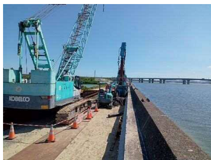
【豊橋杉山海岸 鋼矢板打設状況】
