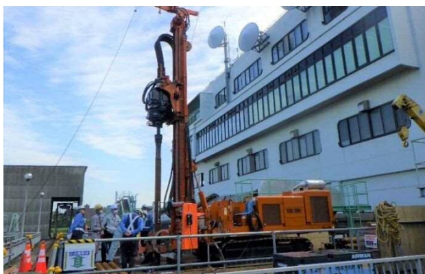
【排水機場の基礎の耐震化】
