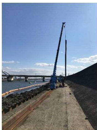
【新川 鋼矢板打設状況】
