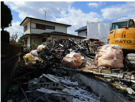
【解体工事現場の様子】
