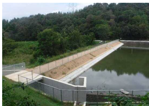
【下蓮池(犬山市)整備完了状況】
