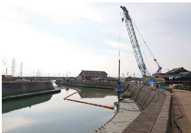
【 蜷川 鋼矢板打設状況】
