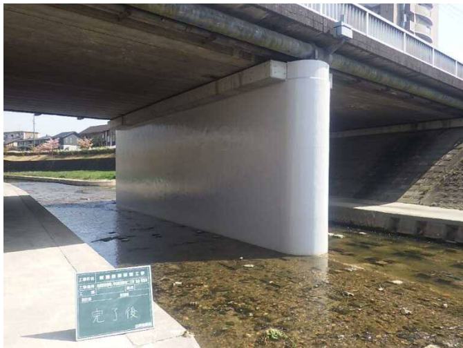
【新藤森橋の耐震補強】
