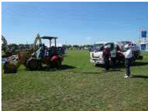
【重機への給油作業の様子】
