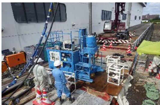
基礎耐震化対策(地盤改良工)実施状況
