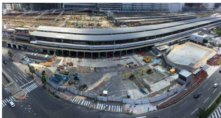
【名古屋駅（中央西工区）】
