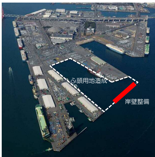
金城心頭の耐震強化岸壁
