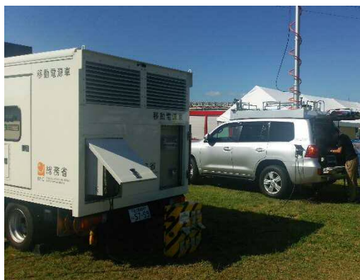
【電源車から送信車両への給電】
