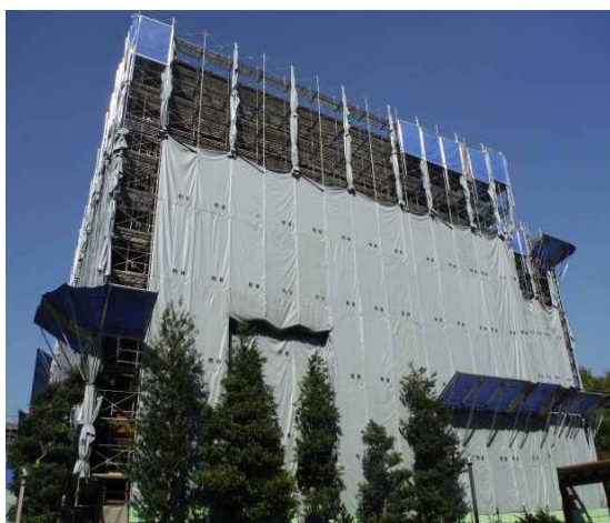
【愛知県議事堂外壁等改修工事】
