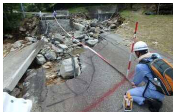
【道路現地調査】 （岐阜県下呂市）
