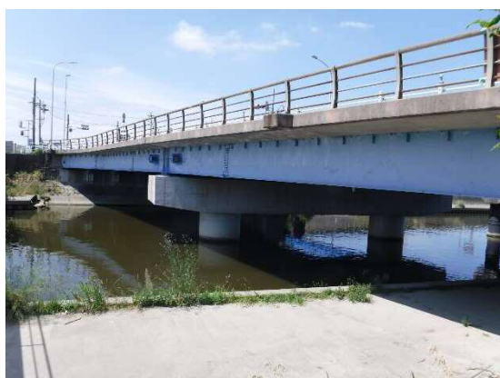
【(主) 蟹江飛島線・新善太川橋】
