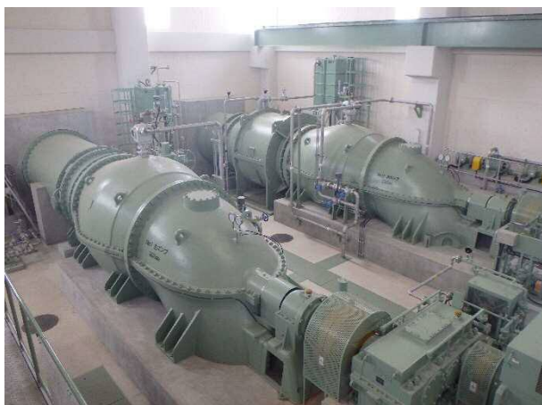
【整備完了状況】
