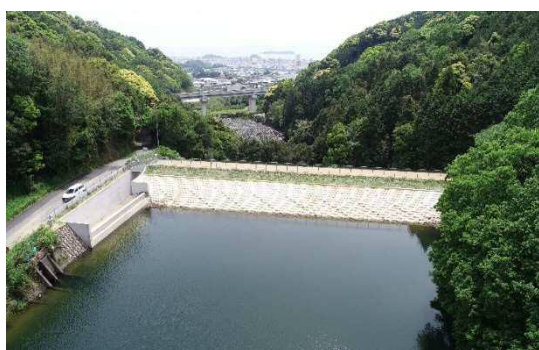
【白龍池(蒲都市)整備完了状況】
