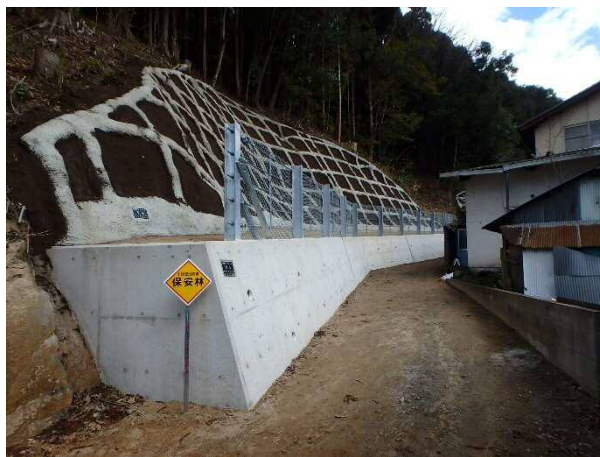
【治山施設の整備】
