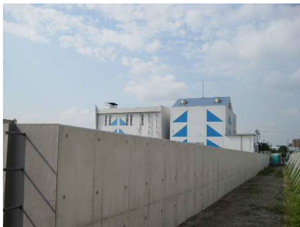
【防潮壁の地震・津波対策（築地東地区）】
