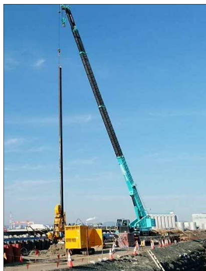
【 豊橋杉山海岸 鋼矢板打設状況】
