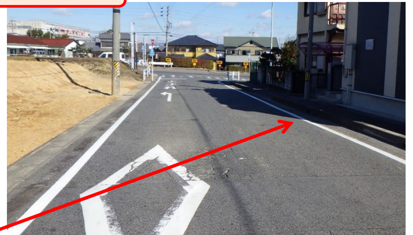
外側線の幅を4.5→5.0mへ変更、外側線の修繕
