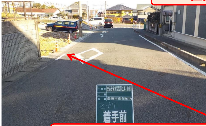
外側線の幅を4.5→5.0mへ変更、外側線の修繕
