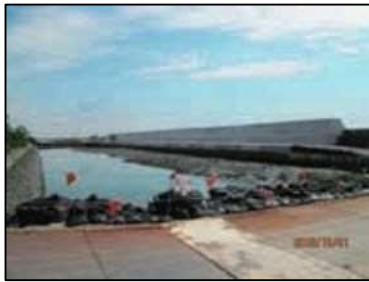
写真 15 高潮防波堤（鍋田堤） 南海トラフ巨大地震に備えて 4.7m から 6.6m に嵩上げされた。(2016. 10. 1 撮影)
