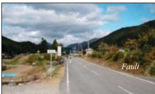
写真2 道路を横切る根尾谷断層（現在）写真1とほぼ同じ位置に Fault の文字を入れてある。 (2005.11.18撮影)
