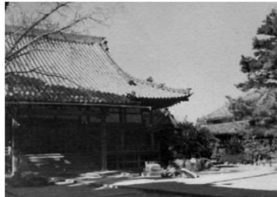
写真8 宗徳寺境内で見られる段差 左右の建物は同じ高さにあったが、地割れによって左側の建物が持ち上げられたため、階段が付けられた。(2016.9.11撮影)
