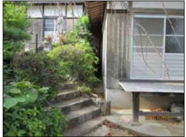
写真8 宗徳寺境内で見られる段差 左右の建物は同じ高さにあったが、地割れによって左側の建物が持ち上げられたため、階段が付けられた。(2016.9.11撮影)
