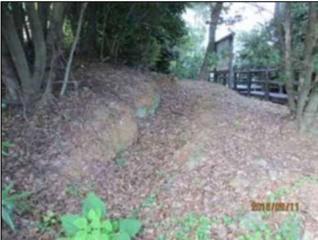
写真9 宗徳寺の北側にある地割れ(写真中央) 南北方向に伸びている。(2016.9.11撮影)
