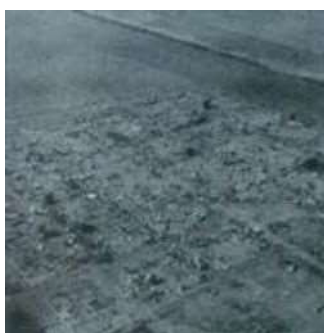
写真 13 堤防の寸断によって高潮氾濫の直撃を受け、跡形もなく流失した半田市の住宅 (中日新聞社『伊勢湾台風の全容』より) 出典 写真 12 に同じ
