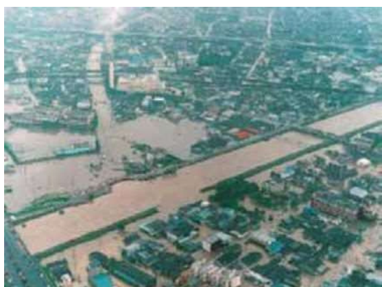
写真18 新川破堤箇所付近
