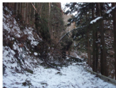
県道古真立津具線（設楽町津具地内）
