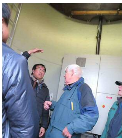
支柱部の内部で説明を受ける
